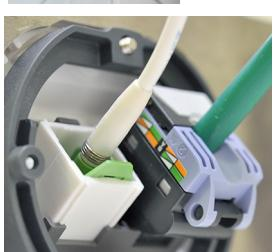
Gehen Sie zum Verteiler, drücken Sie die perforierten Löcher ein und befestigen Sie die Box an einem festen Gegenstand. Dies verhindert, dass die Box beim Einziehen des Kabels mitgezogen wird.
