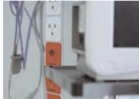
Steckdosen mit Spannungsanzeige sind als Typ 12, 13 und 23 jeweils in 1fach-, 2fach- oder 3fach-Ausführung erhältlich.
