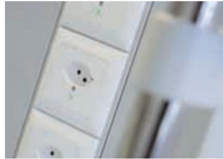
Orange Steckdosen (Sondernetz) weisen auf eine unterbrochene Spannungsversorgung hin.
