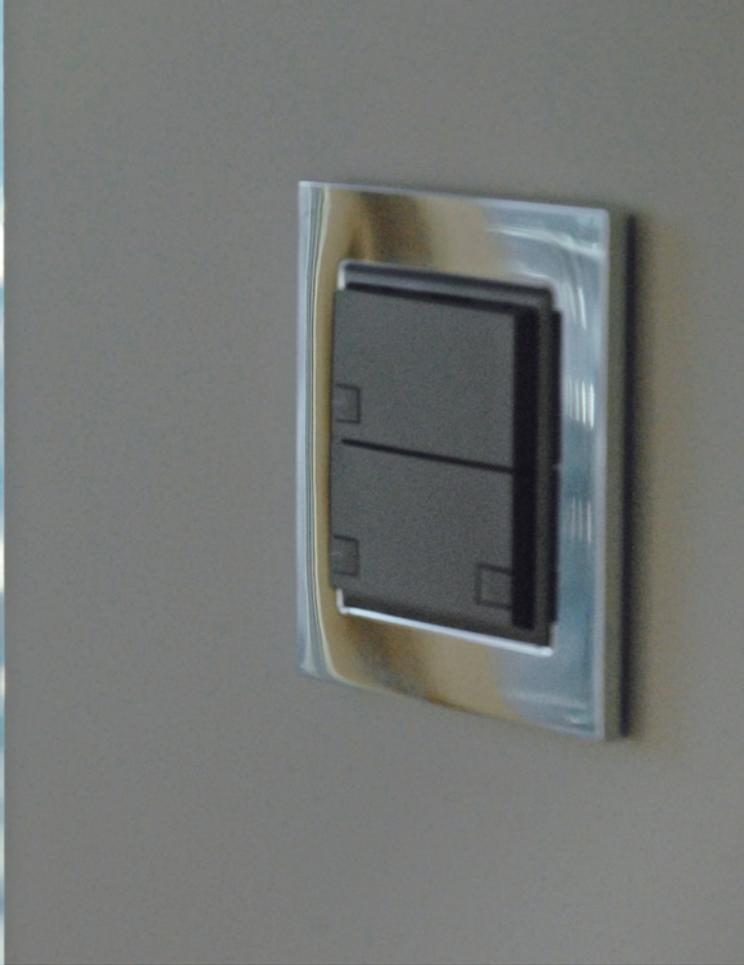
En plus du Touch-Panel 7" multifonctionnel, on utilise des poussoirs KNX dans les divers locaux.
