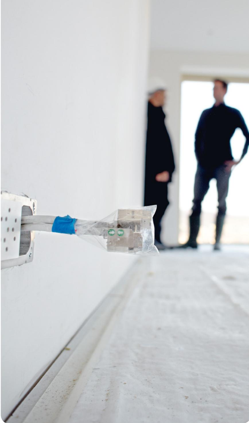
Rapidement installées et compatibles avec la classe E-Links gigabyte: prises de raccordement dirigon.
